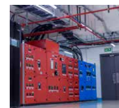
DATA CENTER En joint venture avec OADC 1.200 m 2
