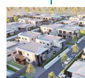
KINSUKA : Meerjarig project (of: Project in meerdere fasen) Fase I/1: bouw van 42 woningen en bijbehorende infrastructuur
