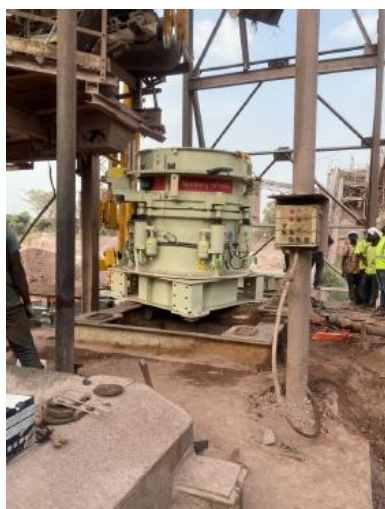
Photos du nouveau concasseur tertiaire et de la nouvelle unité de criblage, en cours d'installation
