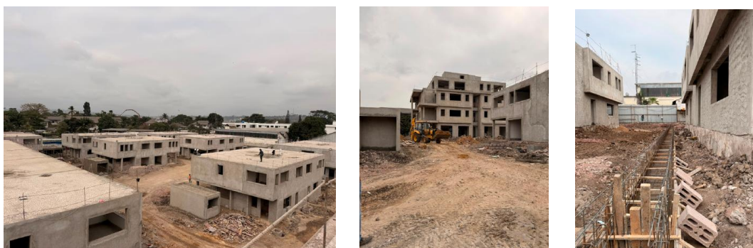
Photographs of the « Quartier des Parcs » construction site
