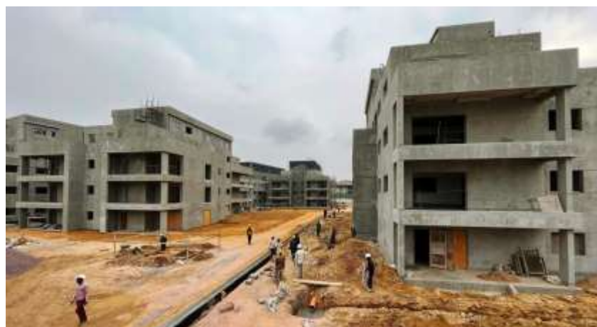
Chantier Promenade des Artistes
