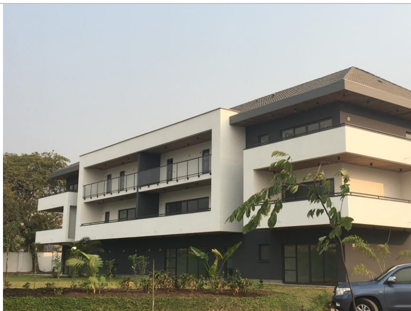
Immeuble appartement achevé du projet « Bois Nobles »
