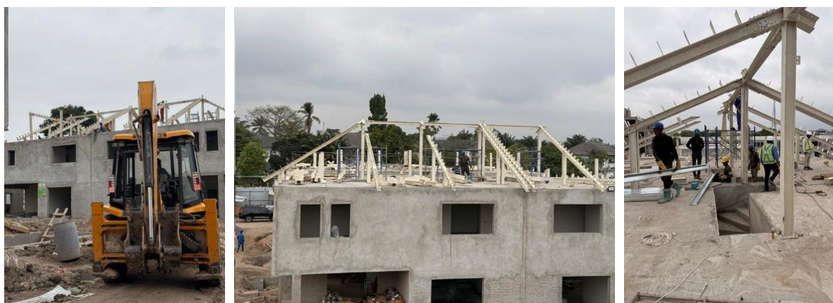
Évolution du chantier « Quartier des Parcs »
