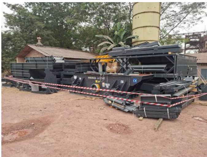
Foto's van de nieuwe tertiaire breker en de nieuwe zeefinstallatie in opbouw
