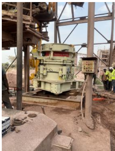
Photos du nouveau concasseur tertiaire et de la nouvelle unité de criblage, en cours d'installation
