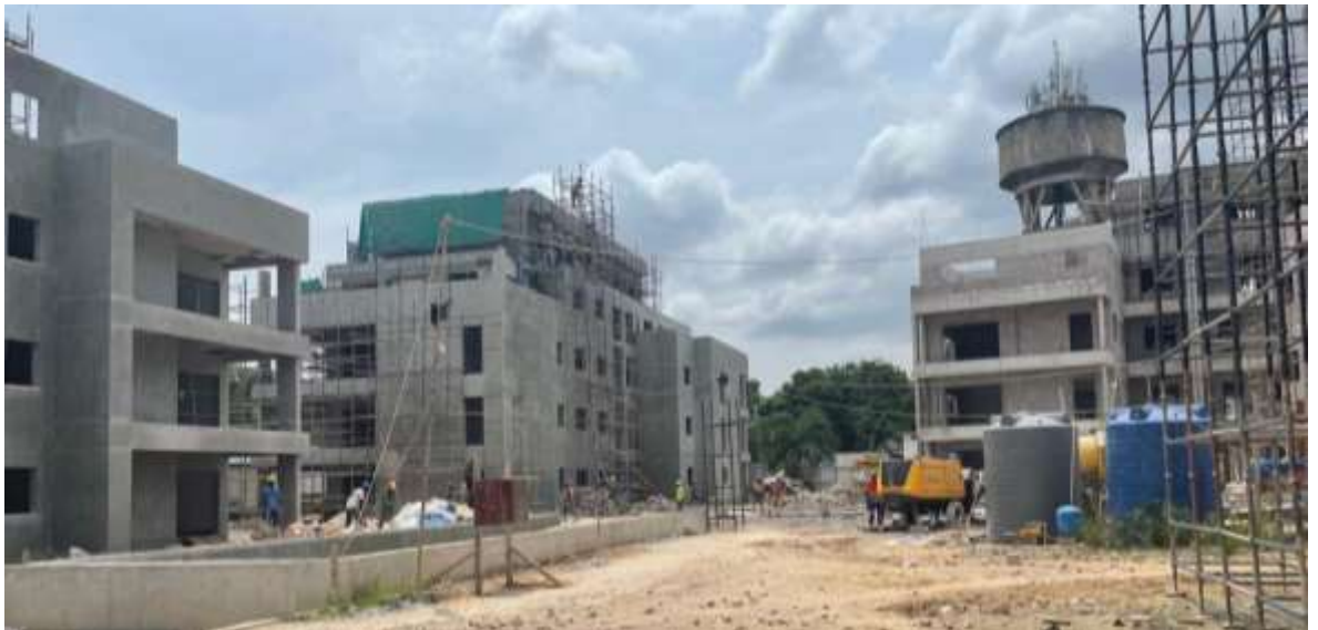
Chantier Promenade des Artistes
