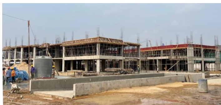
Chantier Promenade des Artistes
