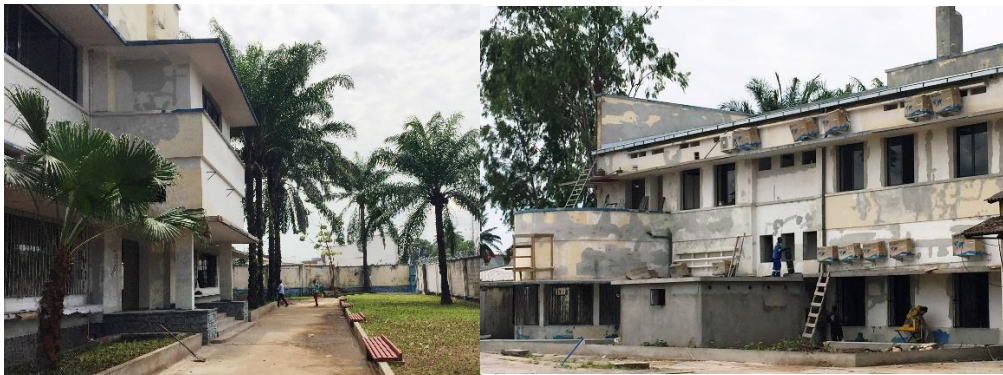
Chantier du Texaf Digital Campus
