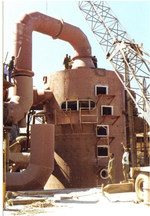
Fig. 6 – fabrication et montage d'une tour de catalyse.
