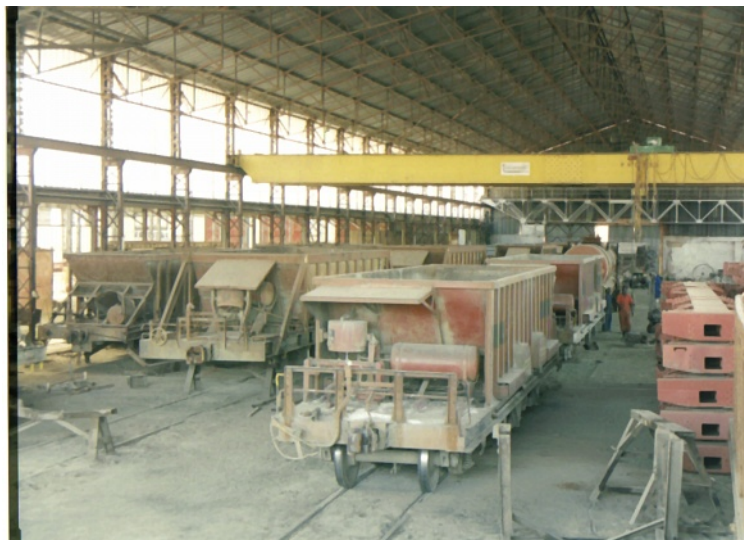
Fig. 4 – Wagons trémies en réparation
