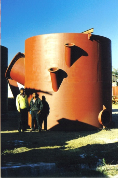
Fig. 10 – Fabrication d'une cuve pour échangeur (usine à acide)
