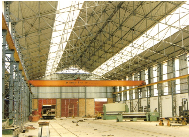
Fig. 1 – hall 7 de Mecelco (115 m sur 20 m de portée avec pont roulant 10 T)
